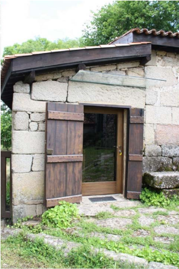
ILUSTRACIÓN 7 VISTA EXTERIOR COA NOVA CARPINTERÍA
