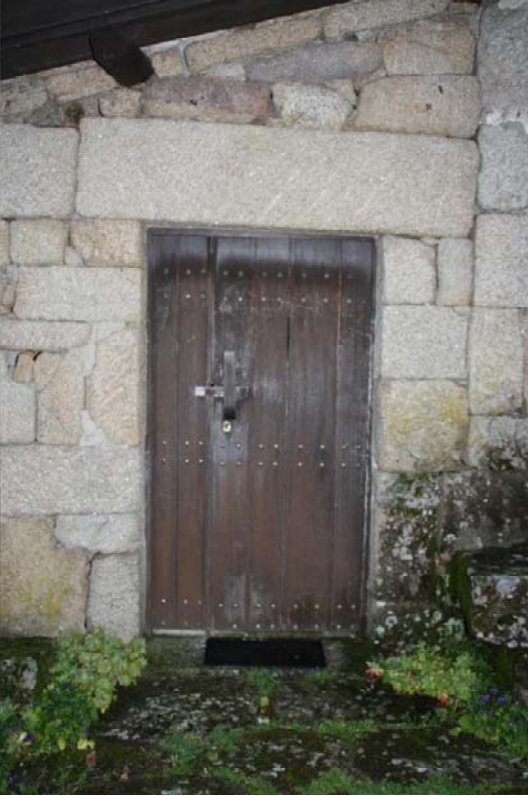
ILUSTRACIÓN 5 ESTADO PREEXISTENTE DA FACHADA EXTERIOR
