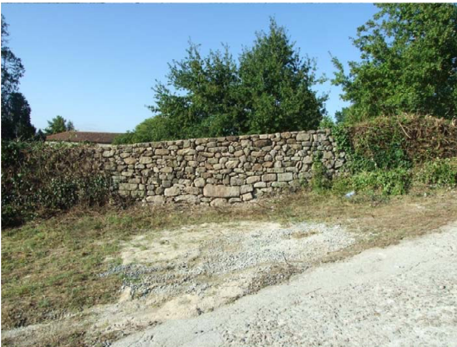
ILUSTRACIÓN 1 ÁREA DA MURALLA SUR RESTAURADA VISTA DENDO O EXTERIOR.
