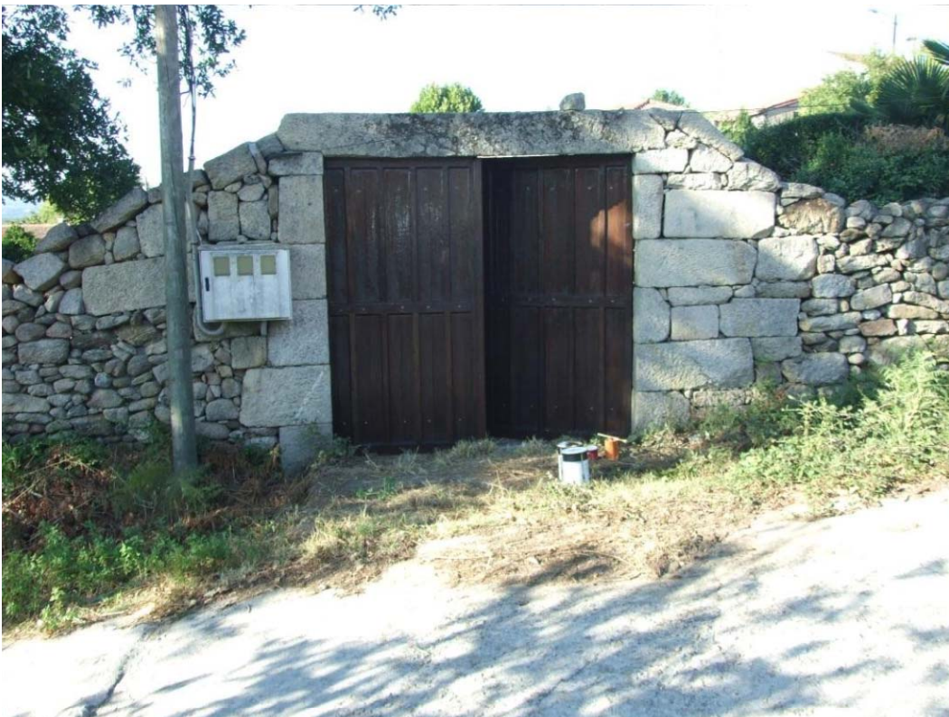
ILUSTRACIÓN 3 VISTA EXTERIOR DO PORTALÓN SE.
