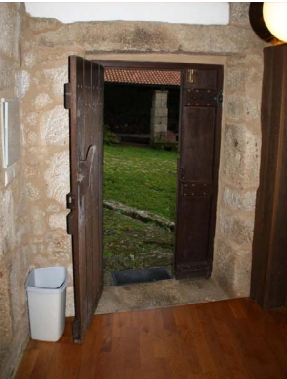
ILUSTRACIÓN 6 ESTADO PREEXISTENTE, VISTA DENDO O INTERIOR.
